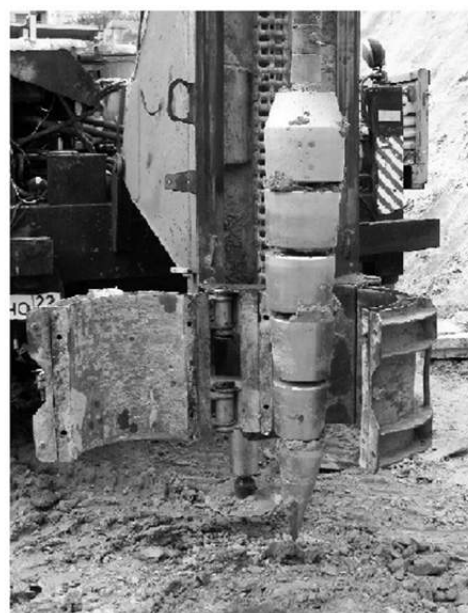
Рисунок 5 – Схема раскатывающего рабочего органа (патент РФ 147223):
