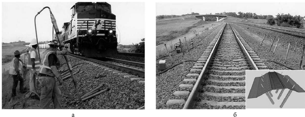
Рисунок 1 – Усиление земляного полотна инъектированием (США) [3]
