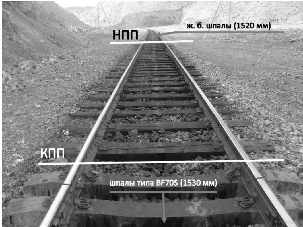
Рисунок 1 – Конструкция отвода уширения колеи с 1520 до 1530 мм с укладкой деревянных шпал (линия Ташгузар – Бойсун – Кумкурган, начало кривой – 137 км ПК 8+50)
