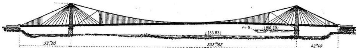
Рисунок 2 – Вантово-висячий мост «Vernaison» через р. Рону, построенный по схеме  $52,5 + 233 + 42,4$  м (1903 г.)
