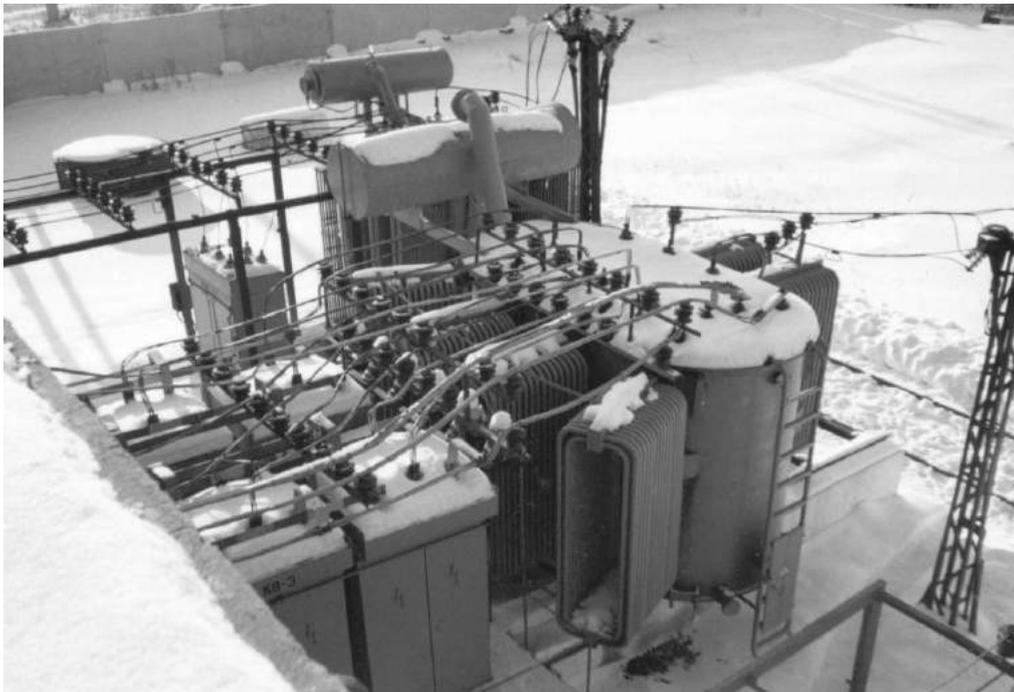
Рисунок 4 – Внешний вид трансформатора типа ТМРУ-16000 и вентильных конструкций типа ТПЕД-3150, модернизированных для двадцатичетырехпульсовой схемы выпрямления
