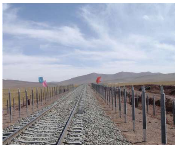
Рисунок 4 – Термосифоны на экспериментальных участках железных дорог Китая: а – наклонные термосифоны; б – вертикальные термосифоны, установленные в два ряда
