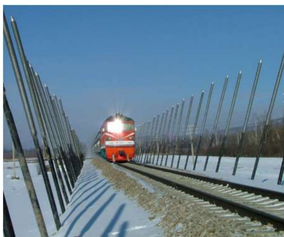
Рисунок 4 – Термосифоны на экспериментальных участках железных дорог Китая: а – наклонные термосифоны; б – вертикальные термосифоны, установленные в два ряда
