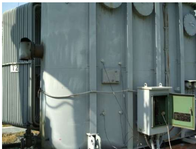
Рисунок 1 – Расположение датчиков на корпусе трансформатора
