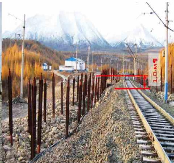
Рисунок 5 – Просадка земляного полотна и скальной охладяющей конструкции на ст. Казанкан. Высота СОУ у моста менее 1 м, октябрь 2008 г.
