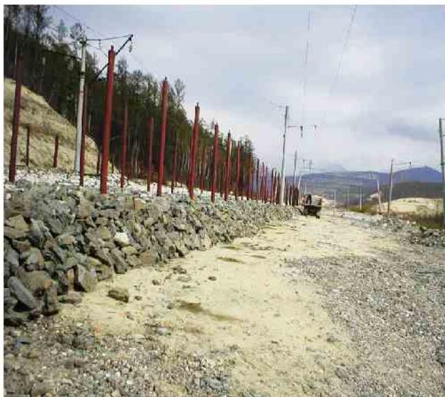
Рисунок 4 – Состояние главного пути на ст. Казанкан. Все СОУ после устройства находятся в одном уровне, их высота составляет около 3 м, октябрь 2003 г.
