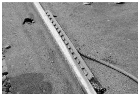
Рисунок 2 – Нанесение лубриканта на боковую грань головки наружного рельса в кривой
